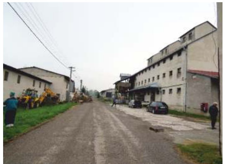
• V súčasnosti RD prevádza rekonštrukciu rozvodu vody v areáli družstva
