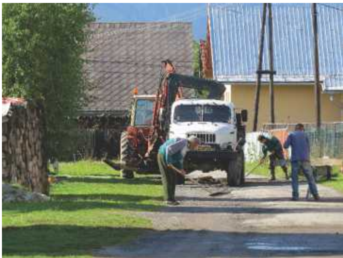
• Na ul. Družstevná boli pred budúcim asfaltovaním vybudované tri priepusty, práce realizoval Peter Taragel'. Pri prácach pomáhali zľava: Ján Fáber, Matej Fronko a Miroslav Fáber
