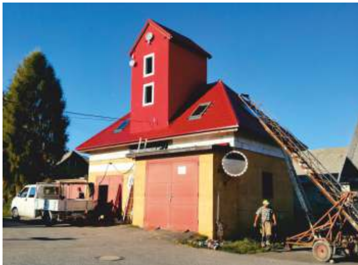
• Montáž krytiny a strešných okien na novom krove hasičskej zbrojnice
