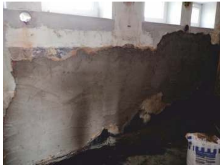
• Po demontáži starej plynovej kotolne bola nutná oprava omietok
