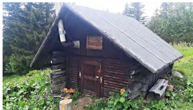
• Koliba na Kotlovej pred rekonštrukciou
